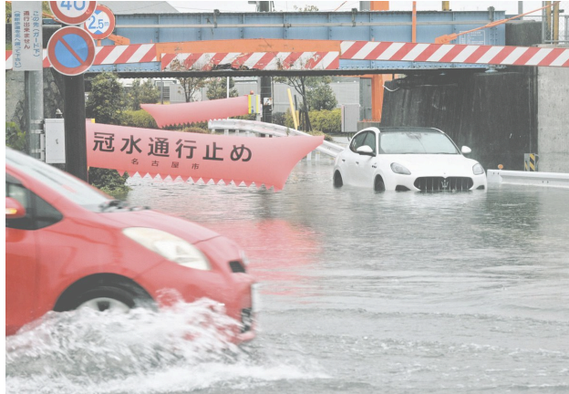
冠水したアンダーパスで立ち往生する乗用車＝9月8日、名古屋市港区で（川添智史撮影）
